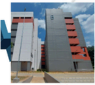
Rusun Jalan Tongkol
