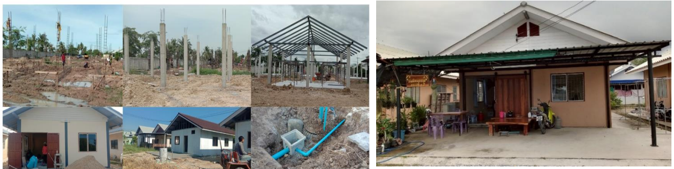
ภาพระหว่างการก่อสร้างและบ้านที่แล้วเสร็จ
