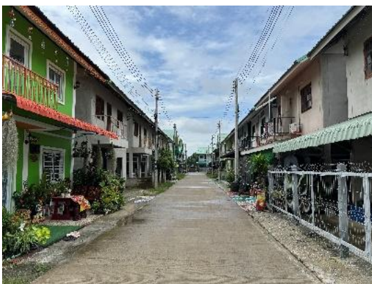
สาธารณูปโภคภายในโครงการบ้านมั่นคง สหกรณ์เคหสถานเมืองพิษณุโลก จำกัด ปัจจุบัน
