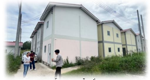
สหกรณ์เคหสถานบ้านมั่นคงคลอง สามแสนสุข จำกัด (จตุจักร) ก่อสร้างบนที่ดินใหม่
