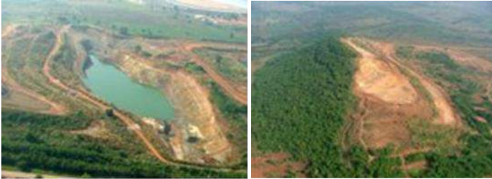
หน้างานบริเวณเขาหม้อ (แปลงสัมปทานเดิมฝั่งเพชรบูรณ์)
