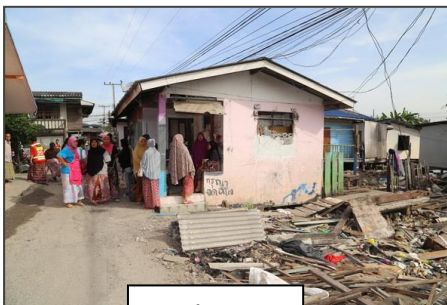
ก่อนดำเนินงาน
