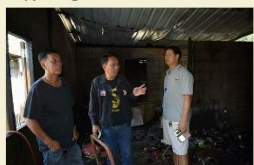
บ้านช่วยเหลือ Before the construction
