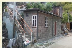
บ้านหลังซ่อม After the renovation
