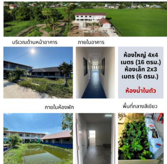
อาคารสวัสดิการที่อยู่อาศัยเพื่อสวัสดิการคนจน “เลียบบวรี 79 เขตหนองจอก” กรุงเทพมหานคร
