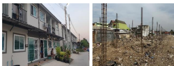
ชุมชนคลองเปรมประชาพัฒนา ก่อสร้างเสร็จ 93 ครัวเรือน ระหว่างสร้าง 61 ครัวเรือน และเตรียมพื้นที่ก่อสร้าง 40 ครัวเรือน
