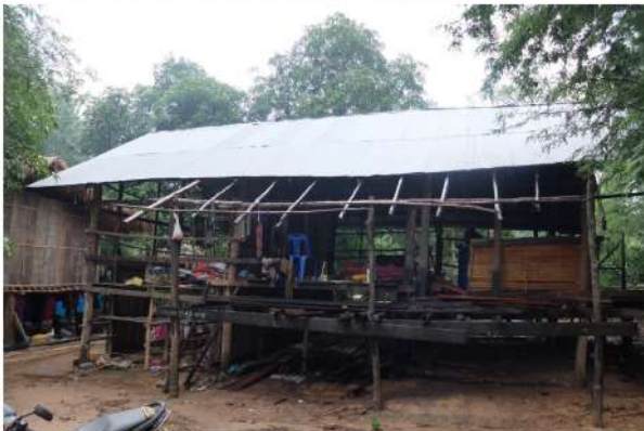
กำลังรื้อบ้านหลังเดิม
