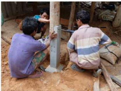
การต่อม็อคอนกรีตกับเสาไม้ เพื่อเสริมความแข็งแรงให้กับเสาบ้าน
