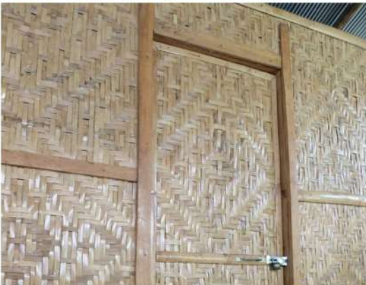
ลักษณะของผนังบ้าน ซึ่งทำจากไม้ไผ่มีลักษณะสามลักษณะคือแบบแนวตั้ง แนวนอนและแบบไม้ไผ่สาน
