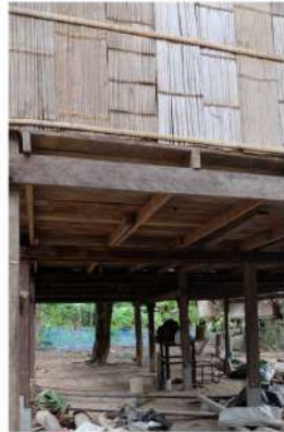
โครงสร้างพื้นไม้ซึ่งมีสามแบบ ได้แก่ โครงสร้างไม้ไผ่ โครงสร้างไม้ยูคาลิปตัส และโครงสร้างแบบใช้ไม้แปรรูป
