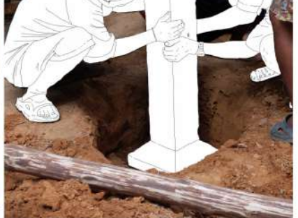
การต่อม็อคอนกรีตกับเสาไม้ เพื่อเสริมความแข็งแรงให้กับเสาบ้าน
