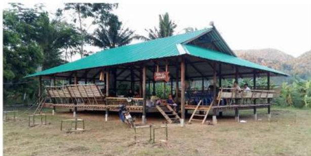
เปลี่ยนโครงสร้างและวัสดุหลังคาศาลาชุมชน ปี 2559
