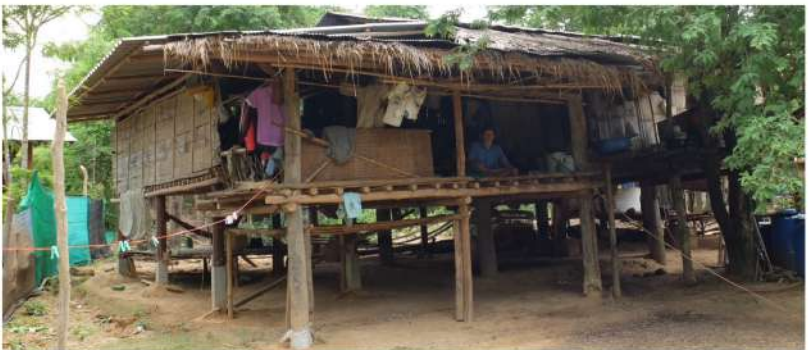
กระบวนการซ่อมแซมและต่อเติมบ้านของนายฟาโมล ลาเตาะ
