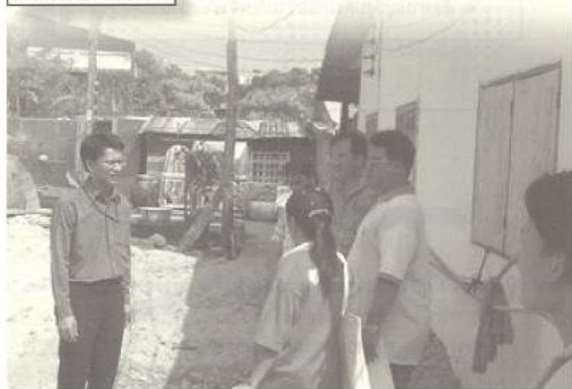
การตรวจรับงานก่อสร้าง
