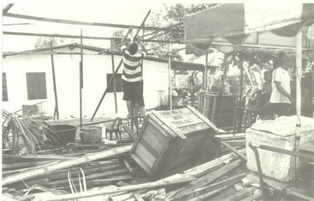
รื้อบ้านเพื่อเตรียมปรับสถานที่สร้างบ้านมั่นคง
