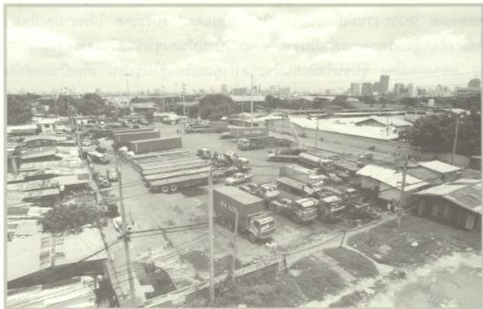
● พื้นที่สร้างชุมชนใหม่ บริเวณลานจอดรถบรรทุกหน้าชุมชนโรงหมู (ก่อนการปรับปรุง)
