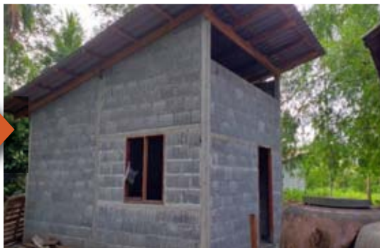
หลังซ่อม
