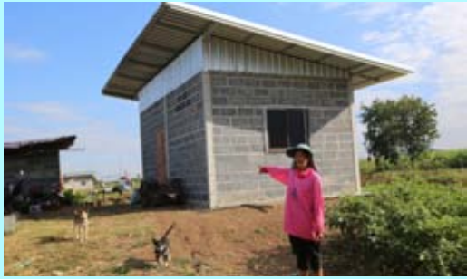
บ้านมั่นคงในพื้นที่ชนบทที่ระบบสาธารณูปโภค ไฟฟ้า น้ำประปายังเข้าไม่ถึง
