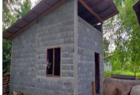
หลังซ่อม
