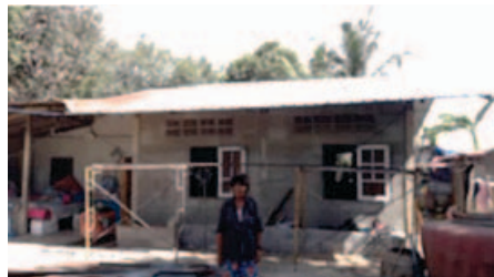
หลังซ่อม
