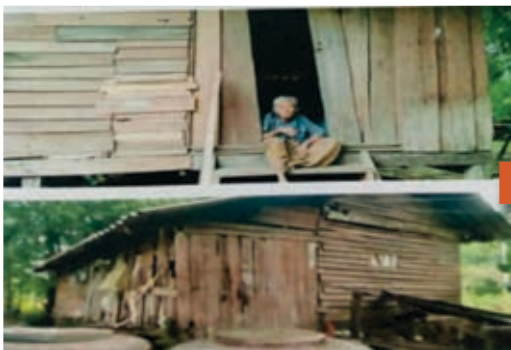
ก่อนซ่อม
