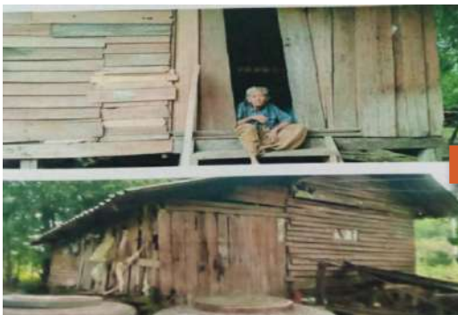
ก่อนซ่อม
