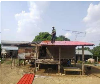
หลังปรับปรุงซ่อมแซม
