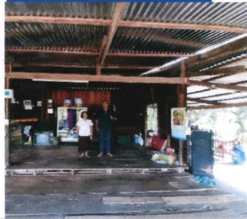
ซ่อมแซมเรียบร้อยแล้ว
