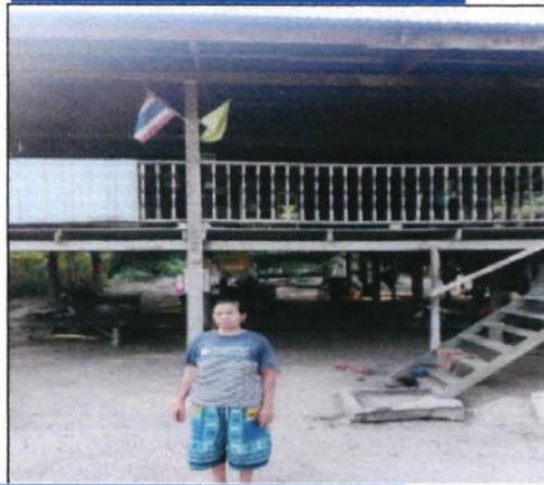
ก่อนซ่อมแซม
