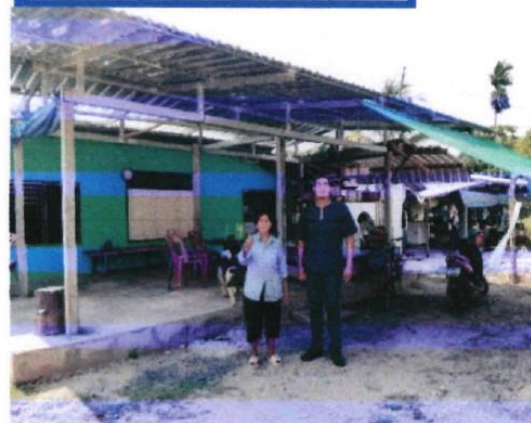
ซ่อมแซมเรียบร้อยแล้ว
