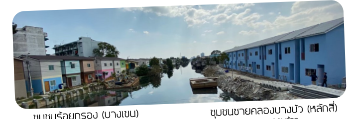
ชุมชนร้อยกรอง (บางเขน) คลองลาดพร้าว
