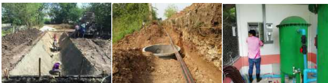
การก่อสร้างระบบก๊าซชีวภาพจากฟาร์มสุกร
